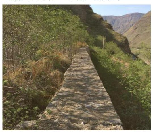
图 1-1 老蟒蛇沟弃渣场挡墙
