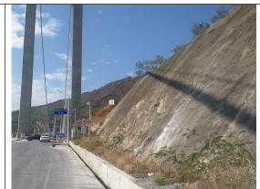
排水沟 (边坡进行锚喷防护)
