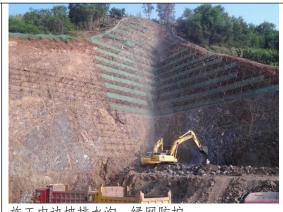
施工中边坡排水沟、绿网防护
