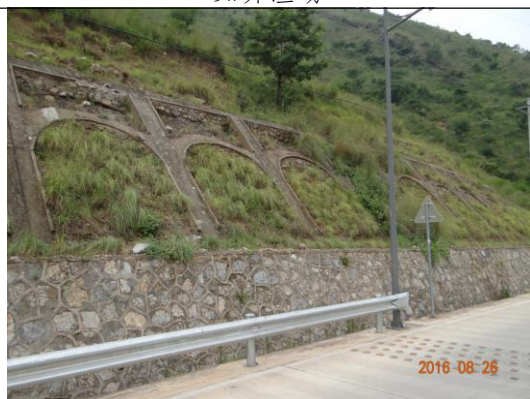
网格梁护坡及植被恢复
