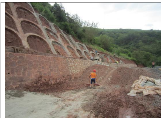
修建网格梁护坡
