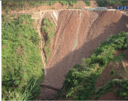
弃渣场拦挡和排水沟
