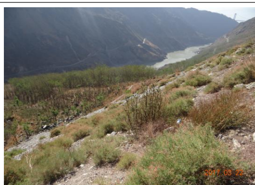
施工场地恢复
