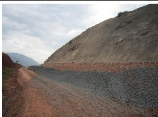
道路喷浆护坡
