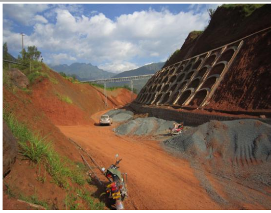
路基边坡网格梁护坡
