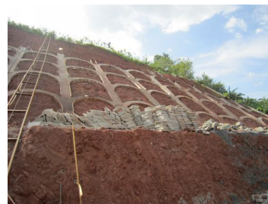
路基边坡网格梁护坡
