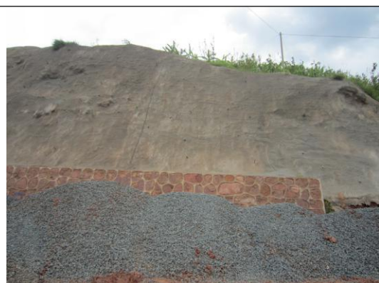
道路喷浆护坡
