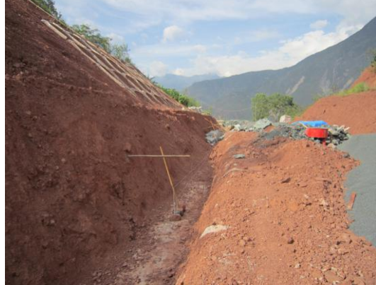
修建道路排水沟
