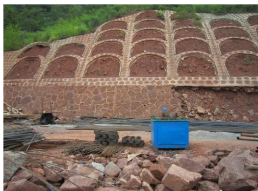
修建网格梁护坡
