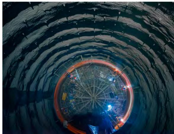
压力钢管竖井段焊接施工
