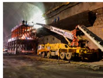
研发应用压力钢管万向运输对装台车
