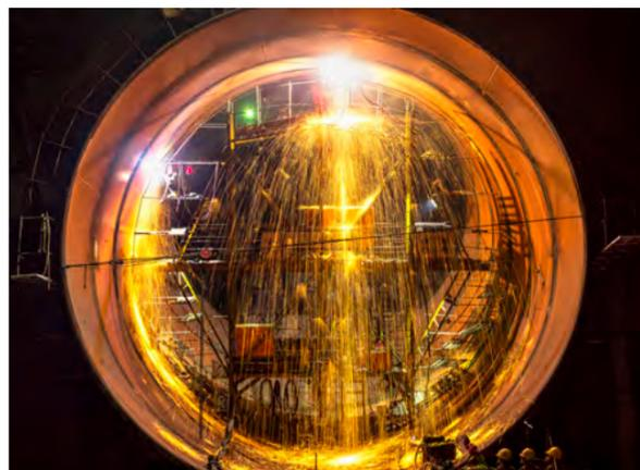
压力钢管焊接施工
