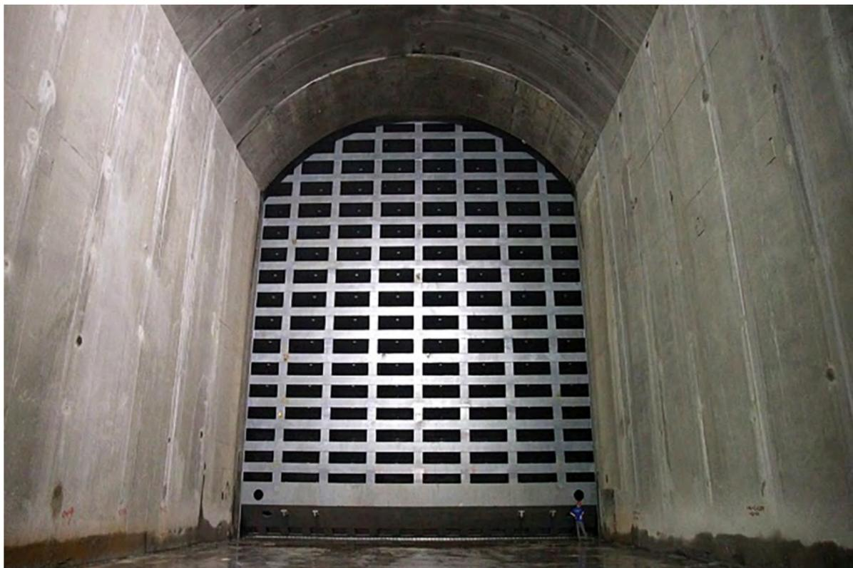
导流洞封堵闸门槽检测
